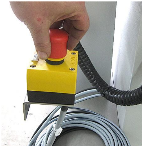
Fig. 5-2 montage de la touche d'arrêt d'urgence
